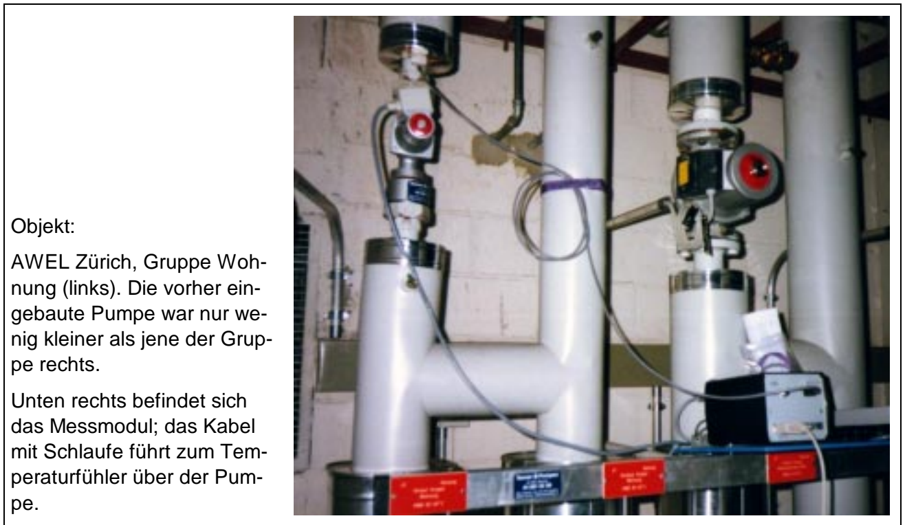
Bild 7 Feldtest-Pumpe in Heizungsverteiler im Testbetrieb
